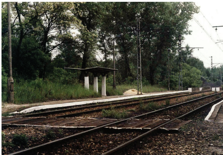
Fot. 1. Przystanek osobowy Szczakowa Most na Magistrali Wschodniej Kopalni Piasku Szczakowa (lato 2001 r.). Wszystkie publikowane fotografie są wykonane przez autora.
