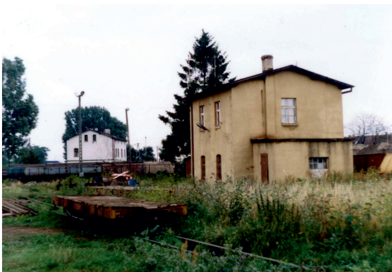
Fot. 10. Budynek biura kolei wąskotorowej cukrowni Tuczno w Wierzchosławicach (lato 2003 r.).
