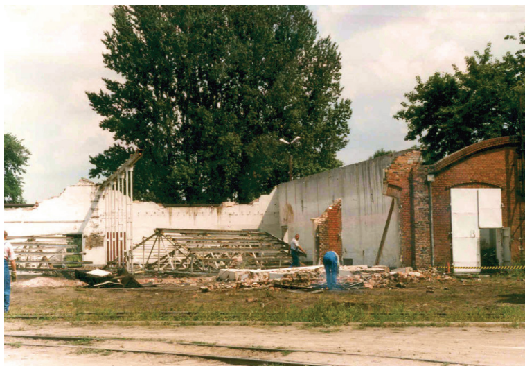
Fot. 14. Rozbiórka warsztatów kolei wąskotorowej cukrowni Kruszwica (lato 2003 r.).
