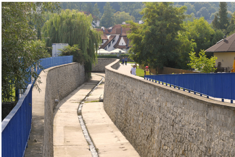
Ryc. 43. Wymurowane koryto ciek Grodarz; miasteczko Kazimierz Dolny. Fot. Sz. Chmielewski
