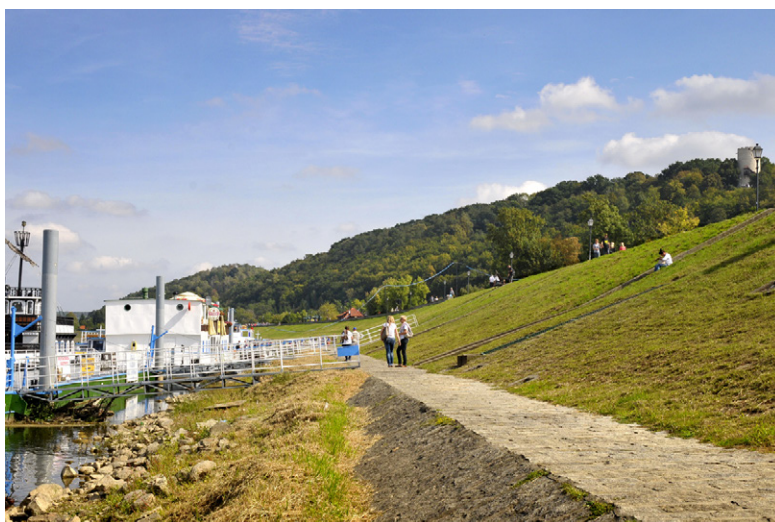
Ryc. 44. Potężny wał przeciwpowodziowy skutecznie odgradza miasteczko Kazimierz Dolny od Wisły. Fot. Sz. Chmielewski
