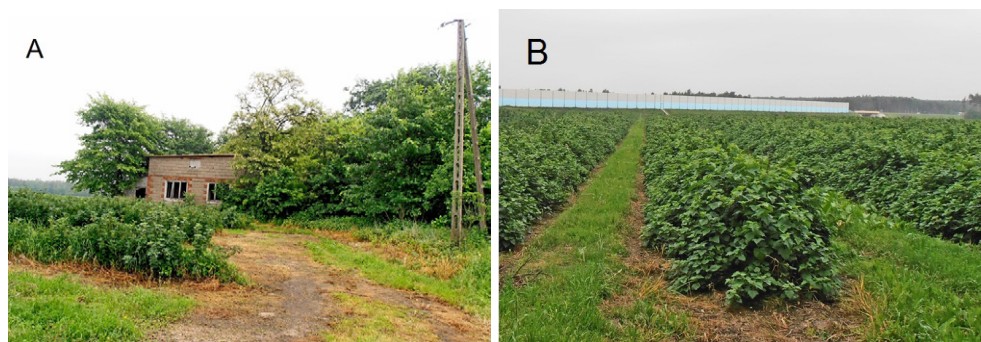
Ryc. 36. Przykład absurdalnej lokalizacji ekranów dźwiękochłonnych w ciągu autostrady A2: niezamieszkałe siedlisko (A) i chroniący je ekran o długości 645 m i wysokości 6 m (B) wybudowany kosztem oszacowanym na 1,1 mln zł. Źródło: NIK 2013, s. 34.
