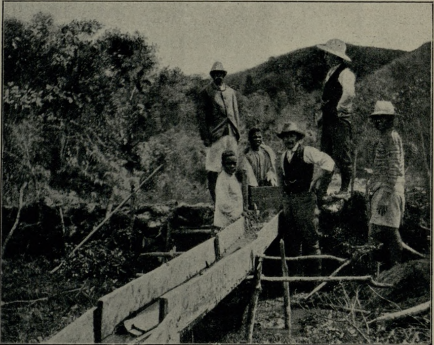
Goldwäscherei in Beparasy. Der Damm mit den sluices.
