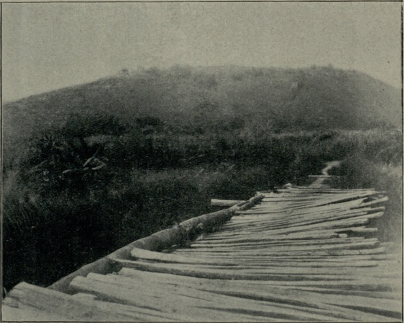
Die »üble Brücke« in Beparasy.
