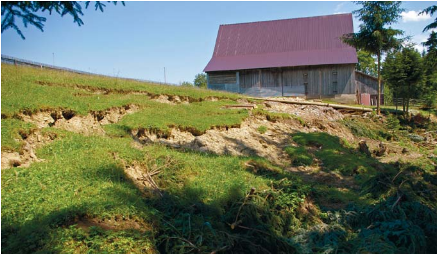
Fot. 3. Płytkie osuwisko zwietrzelinowe powstałe 28.06.2009 r. w górnych partiach Domagalskiego potoku
