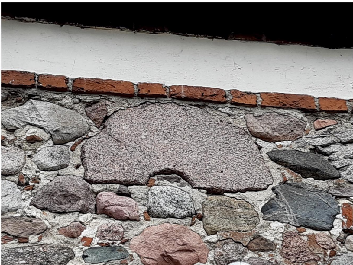
Ryc. 3. Fragment kamienia młyńskiego wmurowanego w ścianę kościoła w Purdzie (fot. D. Brykała)
