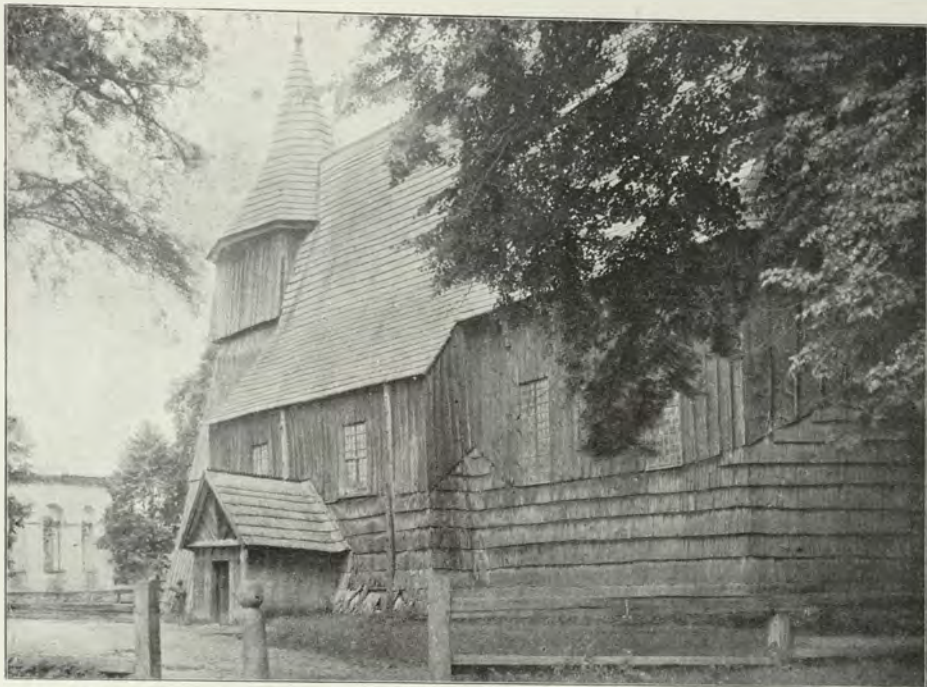
Fig. 185. Libusza. Widok kościoła parafialnego od południowego wschodu.
