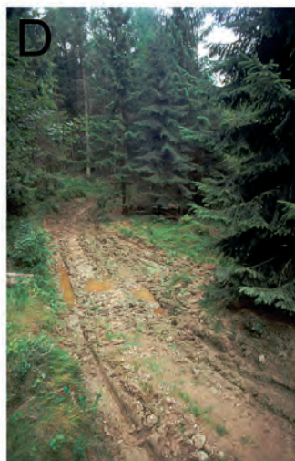
Fot. 24. Bojkowskie drogi stokowe gruntowe przekształcone przez powojenną gospodarkę leśną (A-D – objaśnienia w tekście).
