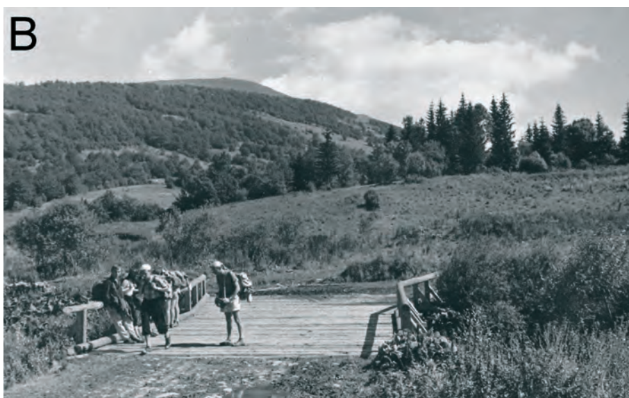
Fot. 11. Stan sieci drogowej na przełomie lat 50. i 60. XX w.: A – utwardzanie traktu Dwernik–Nasiczne–Berehy (fot. T. Sumiński), B – most nad Nasiczniańskim Potokiem w Berehach w miejscu dzisiejszej obwodnicy bieszczadzkiej (fot. J. Blak).
