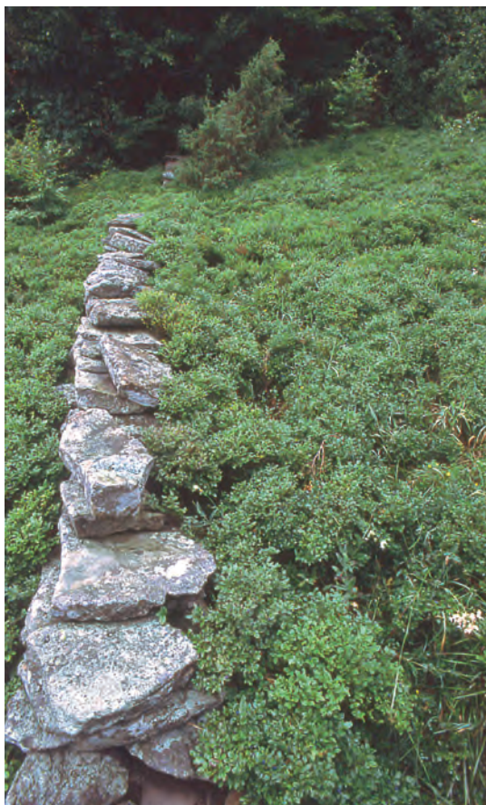
Fot. 23. Kamienny murek oporowy przy drodze stokowej gruntowej w Berehach.
