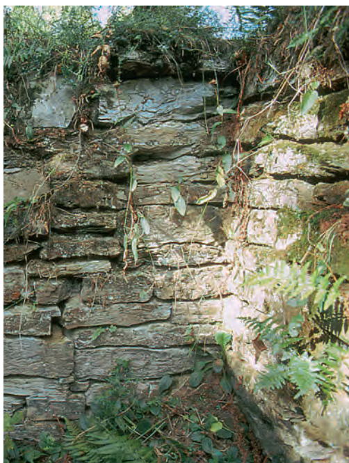
Fot. 13. Ściany piwnic z kawałków piaskowca (Berehy). Sandstone cellar's walls (Berehy Górne village).
