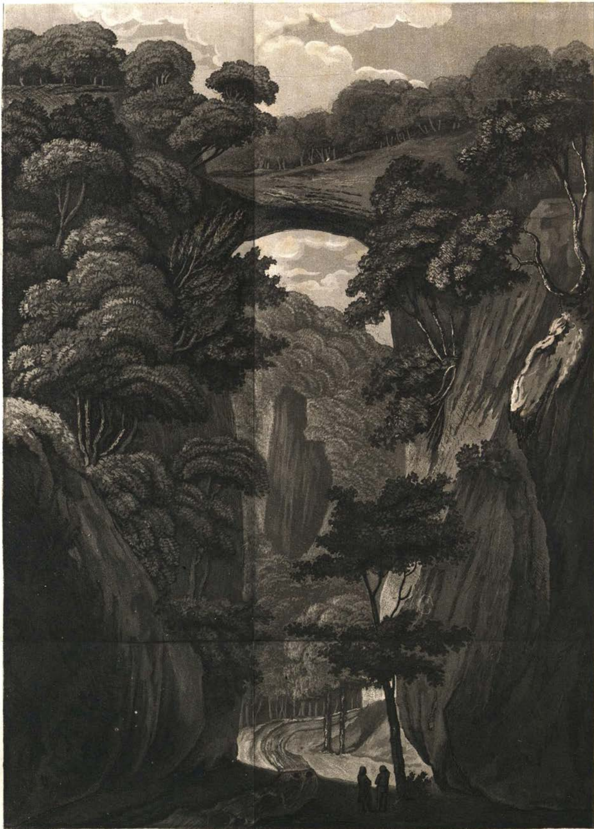
Ansicht der Felsenbrücke
