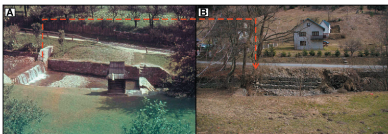
Fot. 12. Elementy zabudowy hydrotechnicznej w korycie potoku Jamne A - Zapora przelewowa dla pomiarów przepływów w 1968 r., B - pozostałość po zaporze w 2008 r. Elements of hydrotechnical structures in Jamne stream channel A - Dam for measuring discharges in 1968, B - Remains of the dam in 2008 Fot. (A) - M. Niemirowski, (B) - A. Bucała
