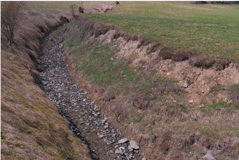
Fot. 8. Wcięcie drogowe modelowane przez płytkie ruchy masowe (zlewnia Jamne) Road cut modeled by the shallow landslide (Jamne catchment)
