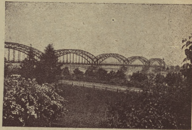
Nowy most kolejowy linii średnicowej w Warszawie
