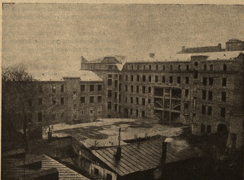
Widok Domu Katolickiego od podwórza; u dołu widać zasklepione sutereny wielkiej sali, której wysokość będzie sięgała do II-go piętra, jak to wskazuje otwór w budynku frontowym.
