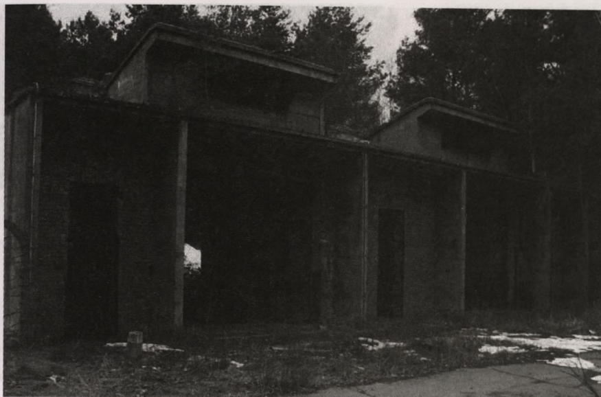
Il. 10. Budynek walcowania prochu (strefa POL, fot. J. Butkiewicz)
