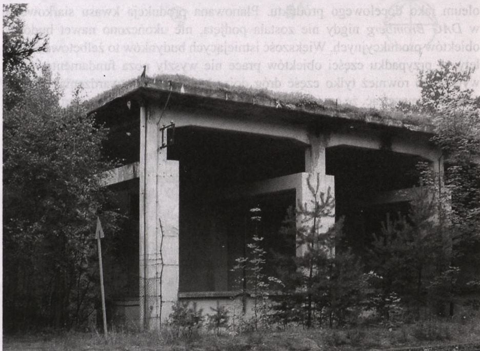
Il. 19. Magazyn (strefa wypełniania amunicji, fot. J. Butkiewicz)
