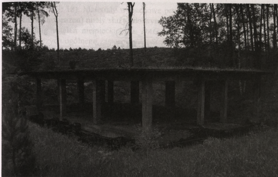
Il. 17. Budynek magazynowy (strefa H 2 SO 4 , fot. J. Butkiewicz)
