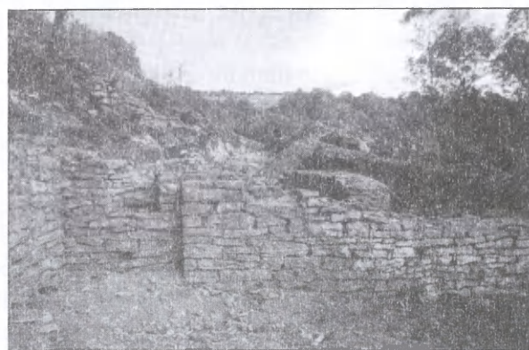
Fig. 9. Dracy (Côte d'Or), village. L'ouverture B 2 dans la porte murée du bâtiment VI (mur nord).
