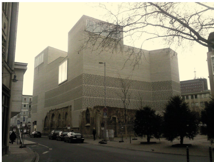
Fot. 5. Madonna in den Trümmern, Kolonia, 2010 (fot. A. Le Blanc)
