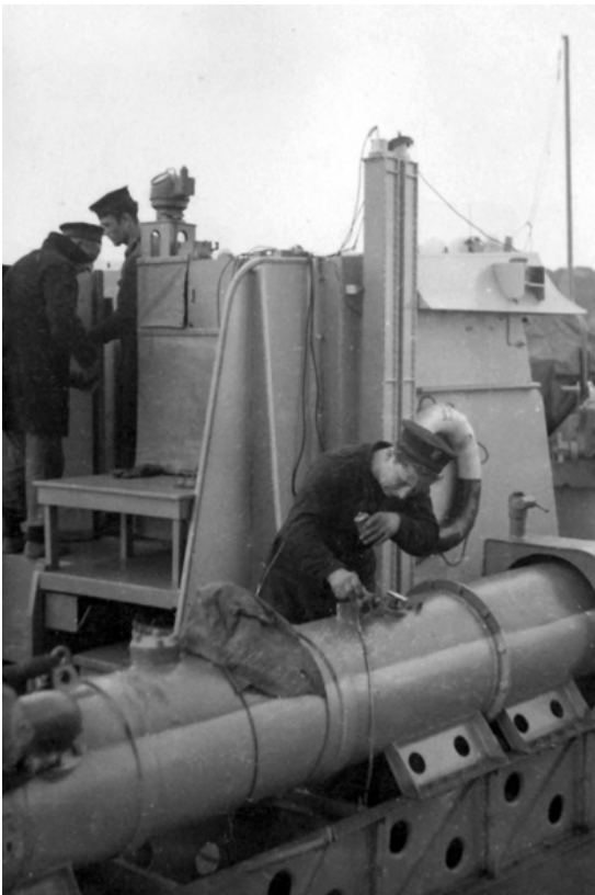
75. Wprowadzanie danych regulacyjnych do torpedy w wyrzutni polskiego ścigacza
