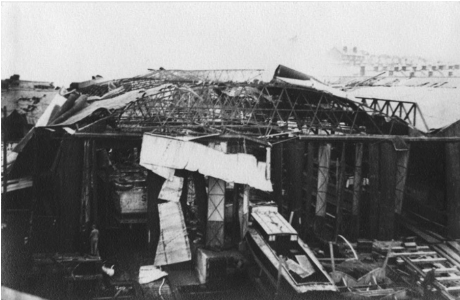
44. Ścigacz „S 1” w hali stoczni White’a w Cowes podczas remontu – tam dosięgła go niemiecka bomba, która przebiła kadłub i wybuchła na posadźce hali. Widoczna litera „S”, na rufie; numer skrywa cień, prawdopodobnie maj 1942 r.
