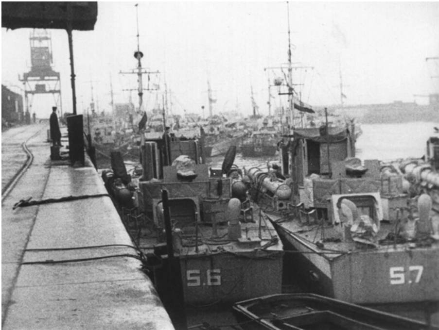
80. ORP „S 6” i ORP „S 7” przy nabrzeżu w bazie. Widoczne wyrzutnie torpedowe
