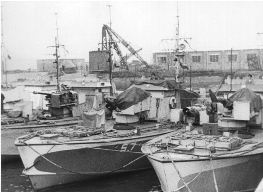
91. Polskie ścigacze w bazie, 1945 r. Na dwóch najbliższych ścigaczach pomosty bojowe oraz działa 6-funtowe (kal. 57 mm) na dziobach przykryte plandekami
