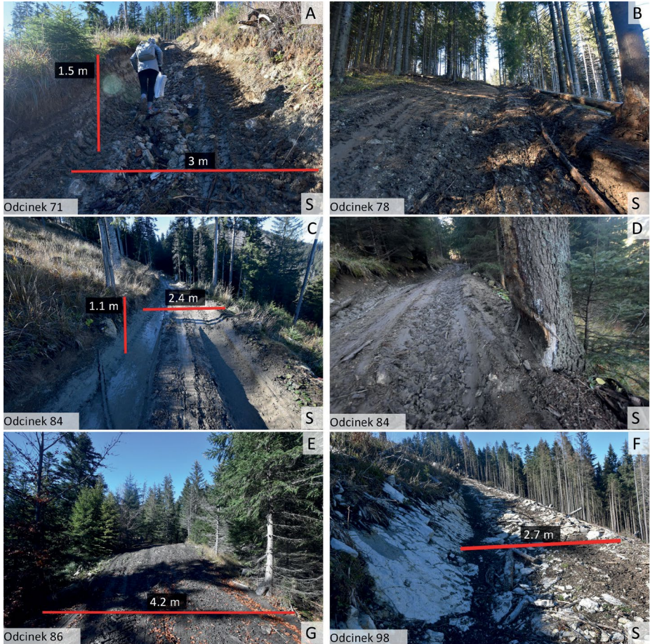
Ryc. 6. Badana droga leśna w rejonie Wielkich Korycisk – przekształcenia w obrębie odcinków poprowadzonych na stokach (S) i grzbiecie (G) (fot. Agnieszka Wojtaszowicz)
