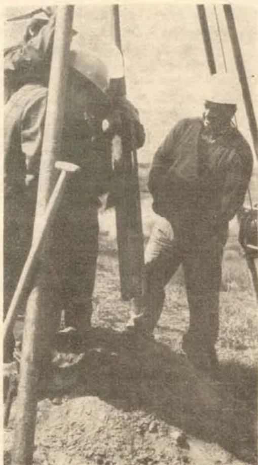
Ryc. 4. Pobieranie próbek: widoczny cylinder wiertniczy z urobkiem
