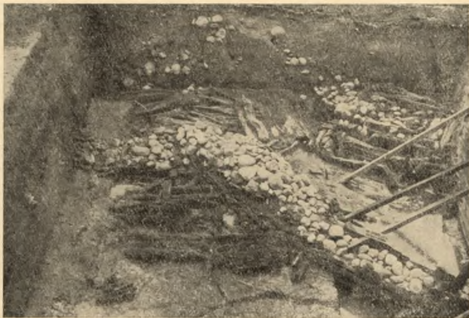
Ryc. 15. Szczątki konstrukcji obronnych wału z IX/X w. składające się z podwójnego pierścienia skrzyń drewnianych wypełnionych kamieniami
