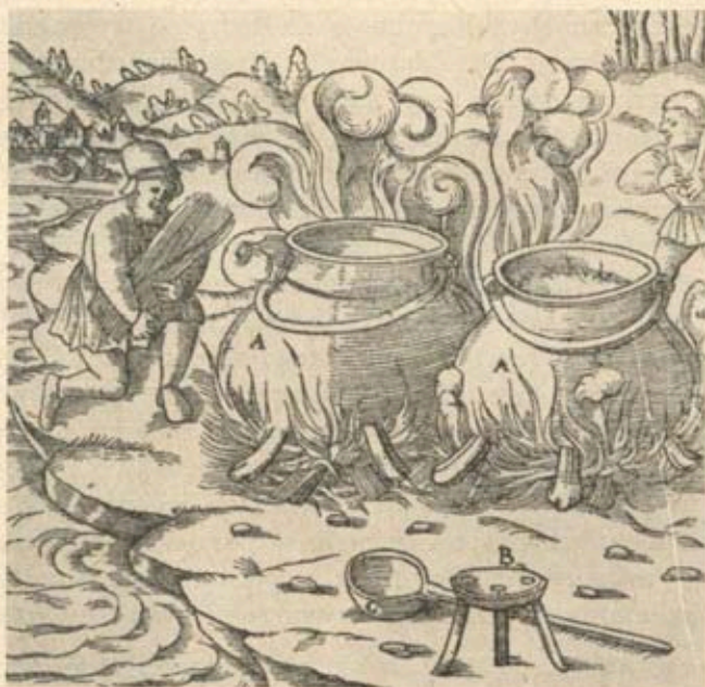
Ryc. 13. Warzenie soli w Niemczech środkowych w XVI w. (wg G. Agricoli)
