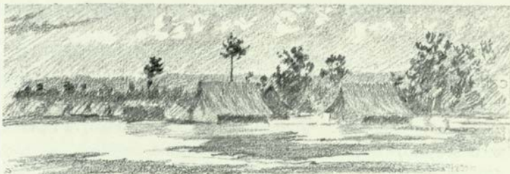
Szpital po ulewnym deszczu.
