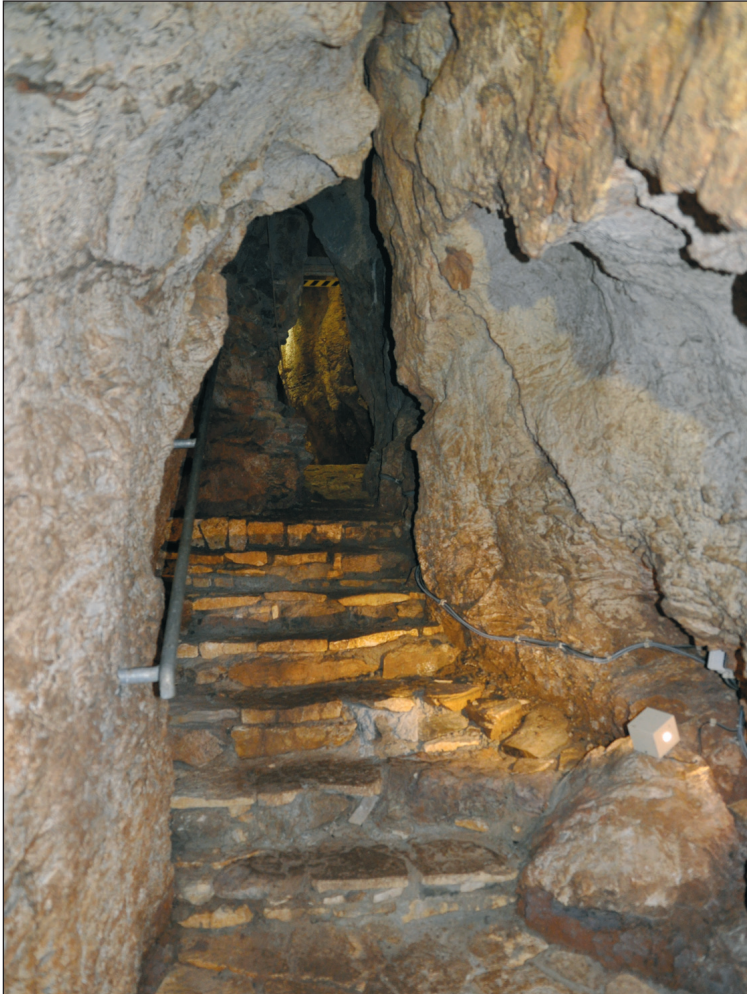
Ryc. 5. Zabezpieczenie i adaptacja krasowej jaskini Kadzielnia w Geoparku w Kielcach. Fot. J. Chmura
