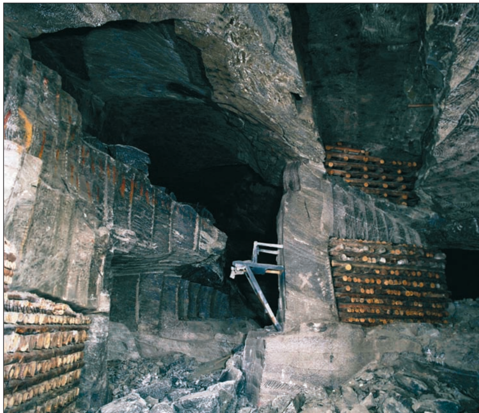
Ryc. 6. Komora „Margielnik” w początkowej fazie prac zabezpieczających. Fot. A. Grzybowski
