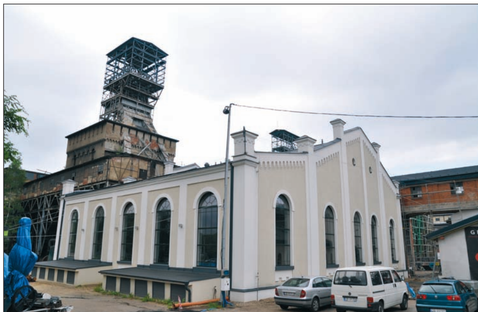
Ryc. 2. Rewitalizacja i adaptacja na cele kulturalne starej kopalni „Julia” w Wałbrzychu.
