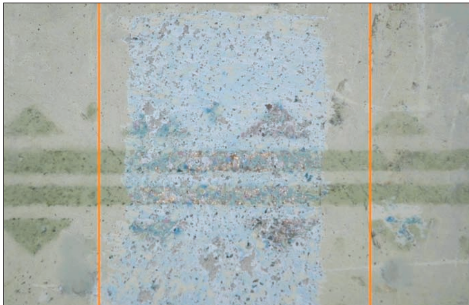
Fot. 4. Świadek wymalowań ścian klatki schodowej zabytkowego budynku przy ul. Żeromskiego 41 w Olsztynie (wyk. E. Doleżyńska-Sewerniak)
