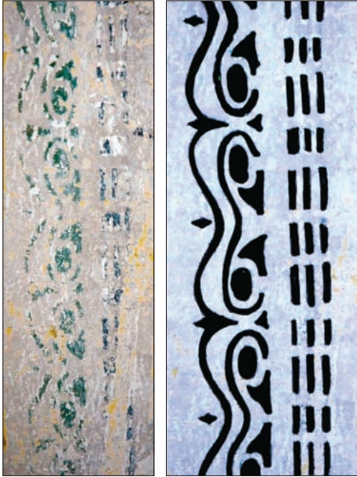
Fot. 3, rys. 3. Świadek wymalowań i schemat rysunkowy wymalowań sufitu klatki schodowej zabytkowego budynku przy ul. Konstytucji 3 Maja w Lidzbarku Warmińskim (wyk. E. Doleżyńska-Sewerniak)
