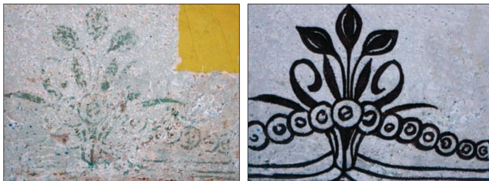
Fot. 1, rys. 1. Świadek wymalowań i schemat rysunkowy wymalowań ścian klatki schodowej zabytkowego budynku przy ul. Konstytucji 3 Maja w Lidzbarku Warmińskim (wyk. E. Doleżyńska-Sewerniak)
