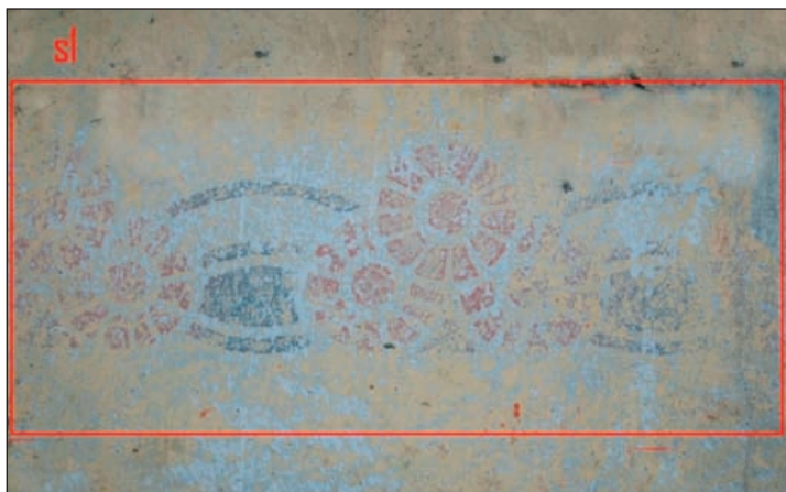
Fot. 6. Świadek wymalowań ścian klatki schodowej zabytkowego budynku przy ul. Żeromskiego 41a w Olsztynie (wyk. E. Doleżyńska-Sewerniak)
