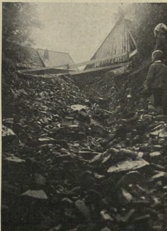
DROGA DO PORĘBY PO WYLEWIE
