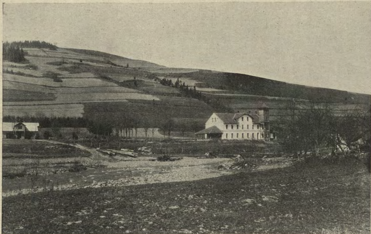
WIDOK OBU BUDYNKÓW KOLONJI
