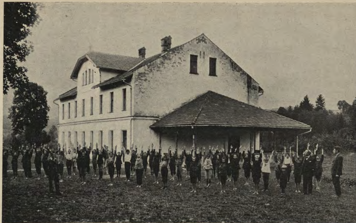
NOWY BUDYNEK KOLONJI W PORĘBIE W.
