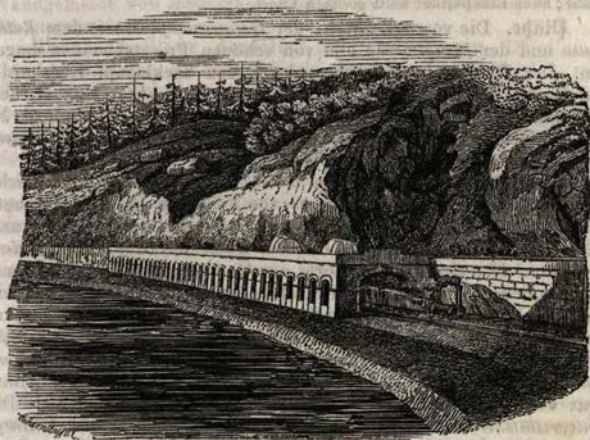
Eisenbahngallerie an der Badlwand.
