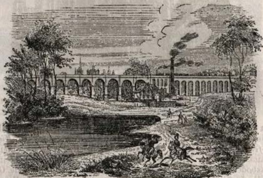
Viaduct bei Aachen.
