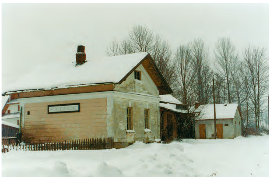
Fot. 6. Przystanek Podczerwone na linii Nowy Targ–Suchá Hora. Tory biegły przed budynkiem (obecnie mieszkalny).
