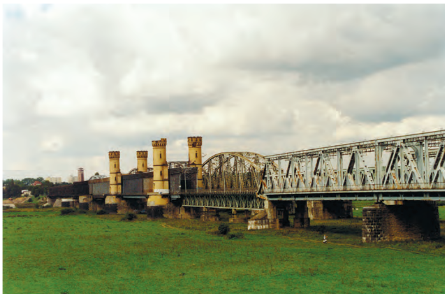
Fot. 1. Pierwszy jednotorowy most przez Wisłę pod Tczewem. Konstrukcja kratowa, pierwotnie z 14 neogotyckimi wieżami zaprojektowana przez Carla Lentza. W momencie oddawania do użytku liczył 1019 m i był najdłuższym mostem w Europie. Wielokrotnie niszczony, oryginalne są 3 przęsła (zalewowe) z 1857 r.
