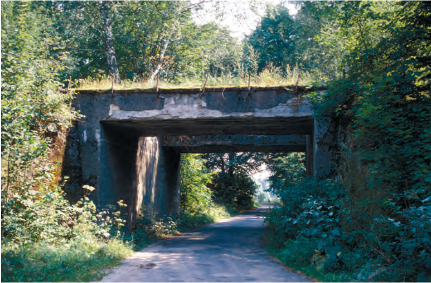
Fot. 36. Podwójne wiadukty koło miejscowości Podągi na rozebranej przez Armię Czerwoną jednotorowej linii Orneta–Morąg. W Prusach Wschodnich, ze względów militarnych, często na jednotorowych liniach budowano podwójne wiadukty lub mosty.
