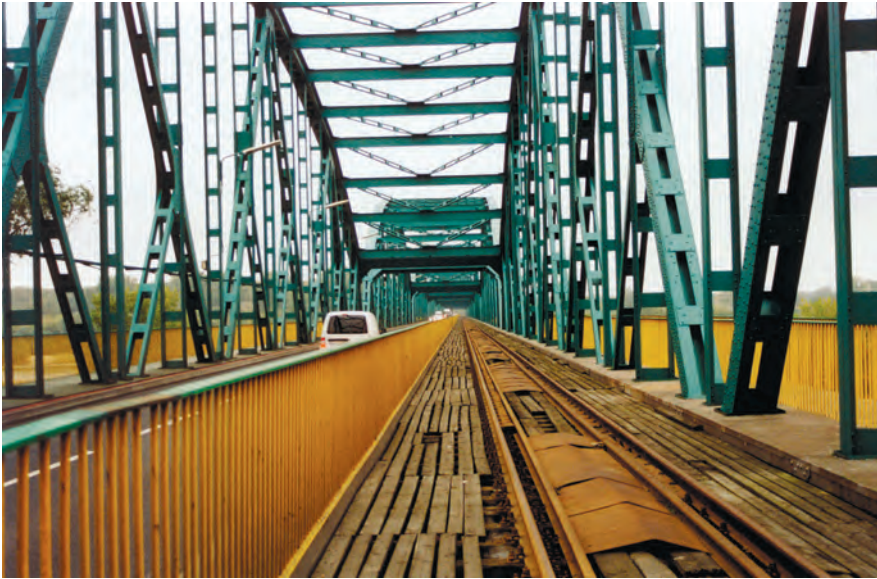
Fot. 4. Jednotorowy kolejowo-drogowy most przez Wisłę pod Fordonem. Oryginalny most z 1893 r. był najdłuższym mostem kolejowym w ówczesnych Niemczech (1325 m). Obecna konstrukcja pochodzi z okresu powojennej odbudowy (1956), ma 1005,5 m długości.
