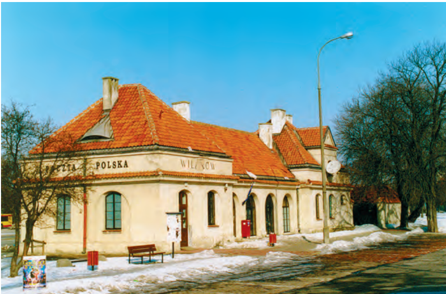
Fot. 7. Dobrze zachowany dworzec Wilanów na wąskotorowej kolei wilanowskiej. Budynek w stylu dworcowym mieści obecnie pocztę.
