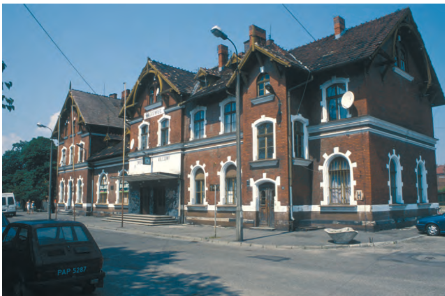
Fot. 24. Częściowo zdewastowany budynek czynnego dworca w Wągrowcu w 2002 r.
