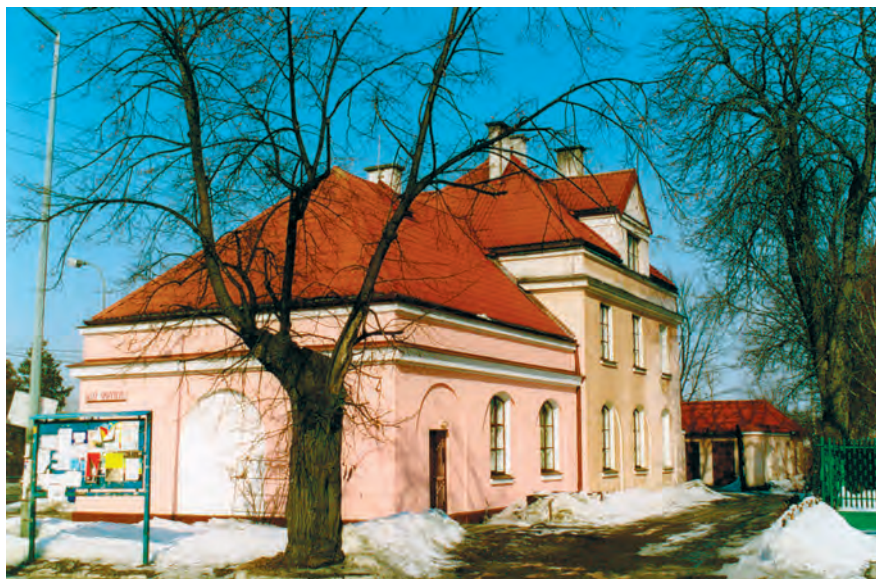
Fot. 8. Budynek dawnego dworca Klarysew na kolei wilanowskiej mieści obecnie sklep i mieszkania.
