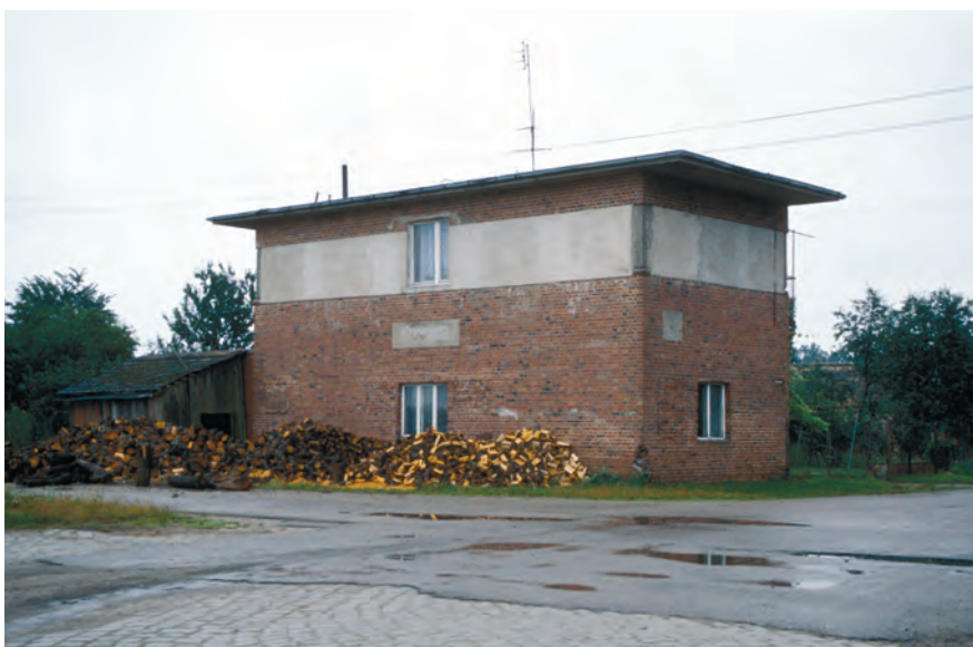
Fot. 54. Budynek nastawni w Sypniewie na rozebranej przez Armię Czerwoną normalnotorowej linii Jastrowie–Czaplinek jest wykorzystywany jako mieszkalny.
