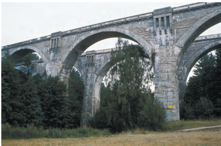
Fot. 38. Podwójne wiadukty w Stańczykach na rozebranej przez Armię Czerwoną jednotorowej normalnotorowej linii Gołdap–Żytkiejmy. Wybudowane w latach 1912–1926 wiadukty mają do 40 m wysokości i ponad 200 m długości; przyciągają amatorów skoków na linach.
