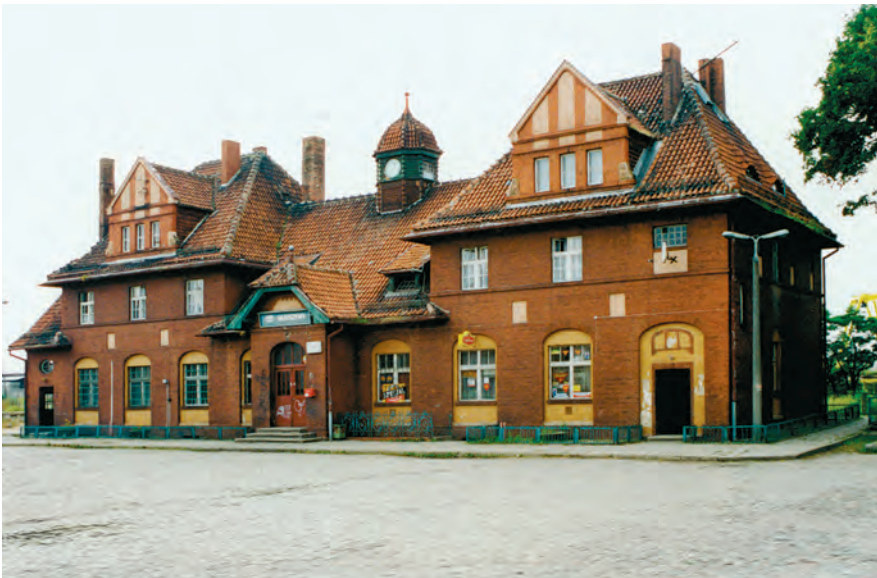
Fot. 64. Dawny dworzec w Skarszewach od lat 1990. wykorzystywany jest na cele mieszkalne i handlowo-usługowe, dzięki czemu nie widać poważniejszych śladów jego dewastacji. Ostatnią linię do Skarszew formalnie zamknięto w 2000 r.
