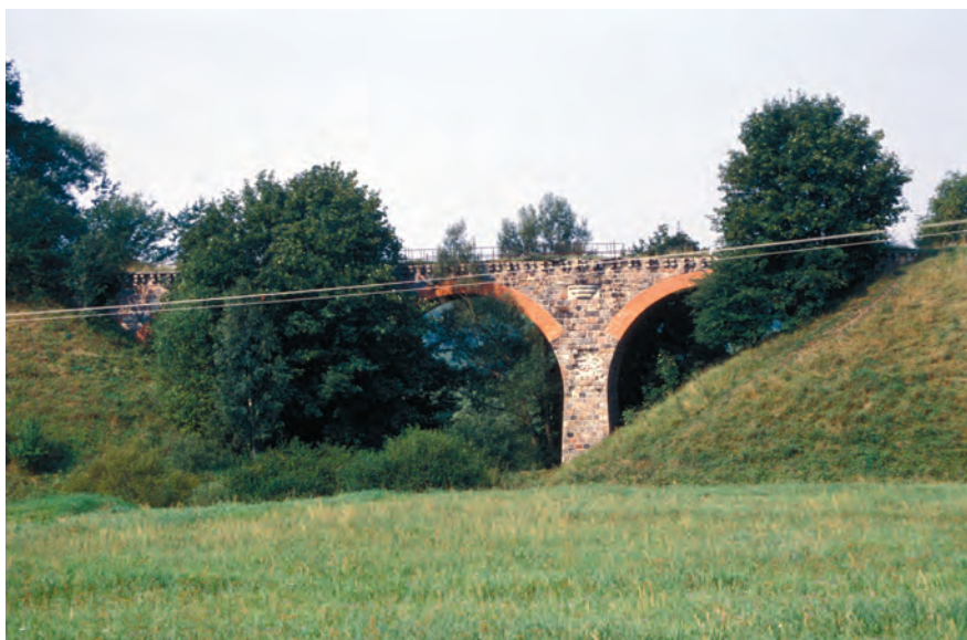
Fot. 35. Kamienno-ceglany wiadukt koło miejscowości Glaznoty na rozebranej przez Armię Czerwoną normalnotorowej linii Uzdrawo–Samborowo
