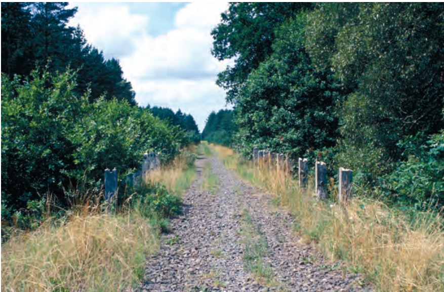
Fot. 57. Pozbawiony barierek most kolejowy przez Wieprzę na rozebranej w końcu lat 1990. normalnotorowej linii Korzybie–Sławno
