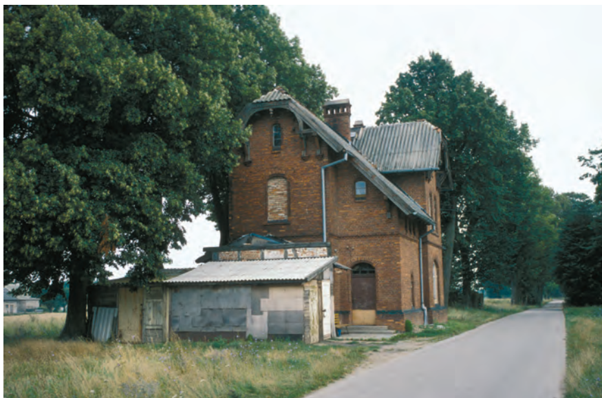
Fot. 61. Budynek stacji Bągart (obecnie mieszkalny) na rozebranej w 1991 r. normalnotorowej linii Chełmno–Unisław Pomorski
