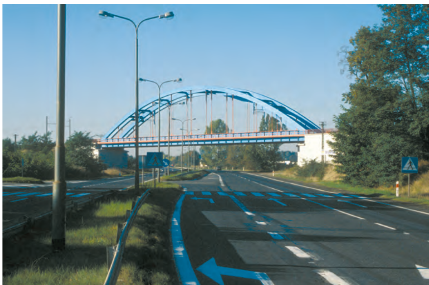
Fot. 23. Odnowiony wiadukt na trasie CMK nad drogą szybkiego ruchu Warszawa–Katowice w pobliżu miejscowości Zawady
