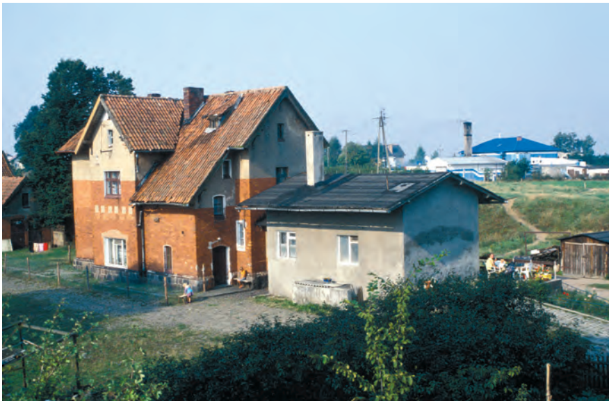
Fot. 60. Budynek końcowej stacji kolei normalnotorowej w Uzdrawiu (obecnie mieszkalny). Linię do Turzy Wielkiej rozebrano w latach 1990.
