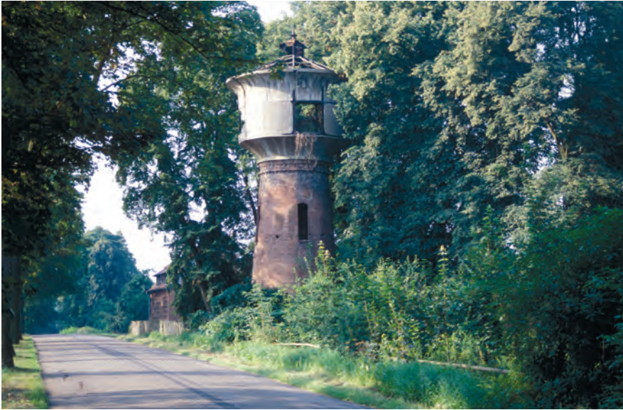
Fot. 50. Wieża wodna w Lubniewicach na rozebranej przez Armię Czerwoną normalnotorowej linii Rudnica–Sulęcín
