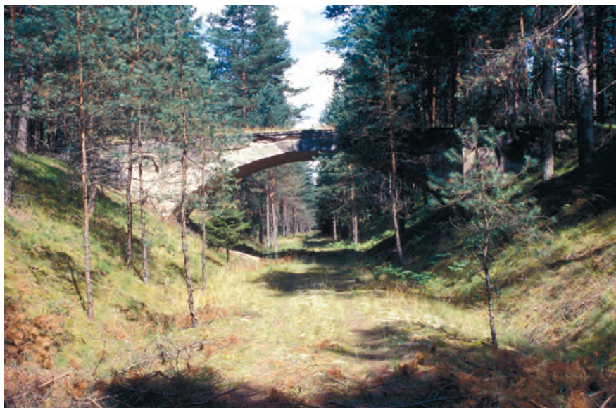
Fot. 34. Lekki żelbetowy wiadukt nad przekopem rozebranej przez Armię Czerwoną normalnotorowej linii Polanów–Korzybie
