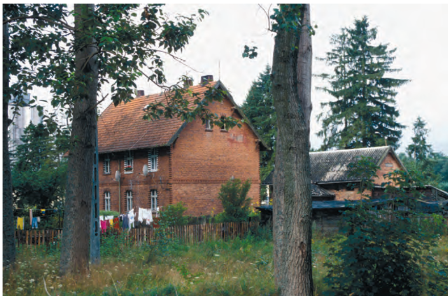
Fot. 52. Dobrze zachowany budynek przystanku Cewice na rozebranej przez Armię Czerwoną linii Bytów–Lębork jest wykorzystywany jako mieszkalny. Widoczne ślady niemieckiej nazwy Zewitz. Po odbudowie krótkiego odcinka do Lęborka w 1947 r., Cewice znalazły się na trasie bocznicy do lotniska.
