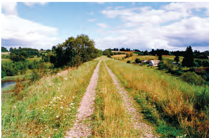
Fot. 45. Wysoki nasyp koło Kramarzyn na rozebranej przez Armię Czerwoną normalnotorowej linii Miastko–Bytów. Widoczne pozostałości tuczni
