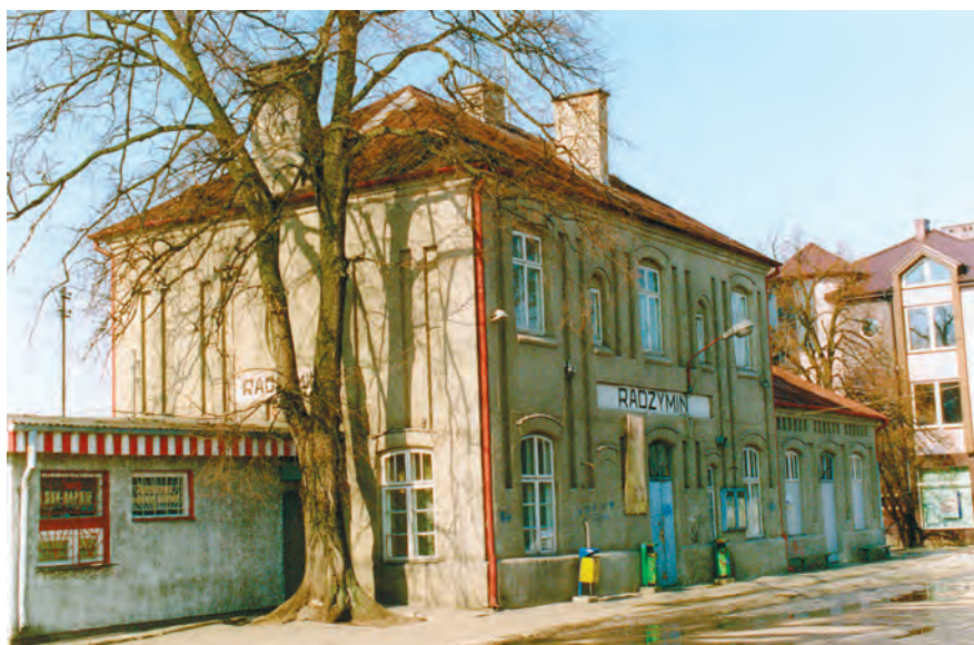
Fot. 9. Budynek dawnego dworca Radzymin na wąskotorowej kolei mareckiej jest obecnie wykorzystywany przez PKS.
