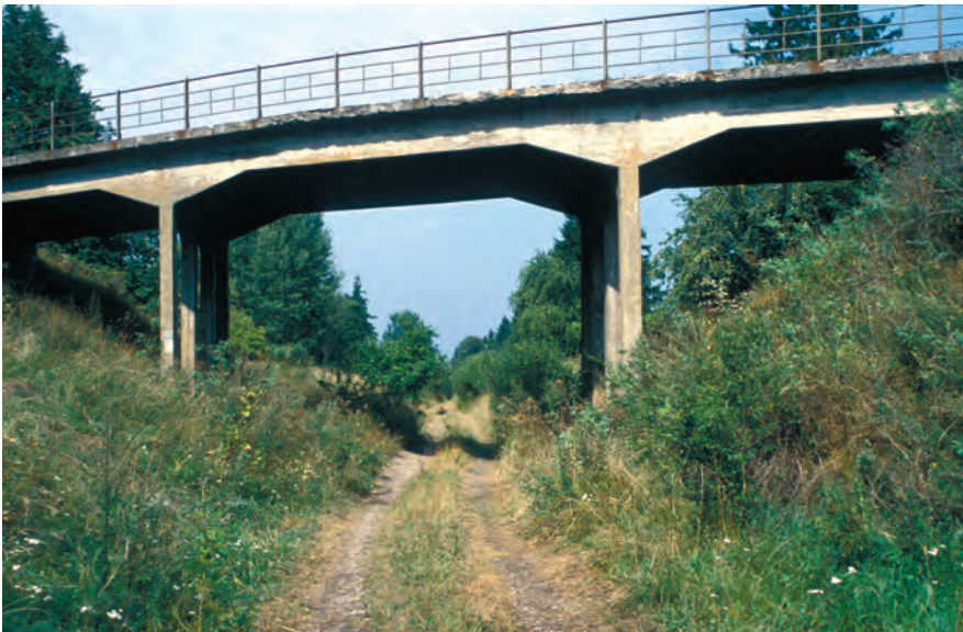
Fot. 37. Lekki żelbetowy wiadukt koło Brzostowa nad przekopem rozebranej przez Armię Czerwoną normalnotorowej linii Węgorzewo–Rudziszki. Obecnie przekop wykorzystywany jest jako ścieżka rowerowa.
