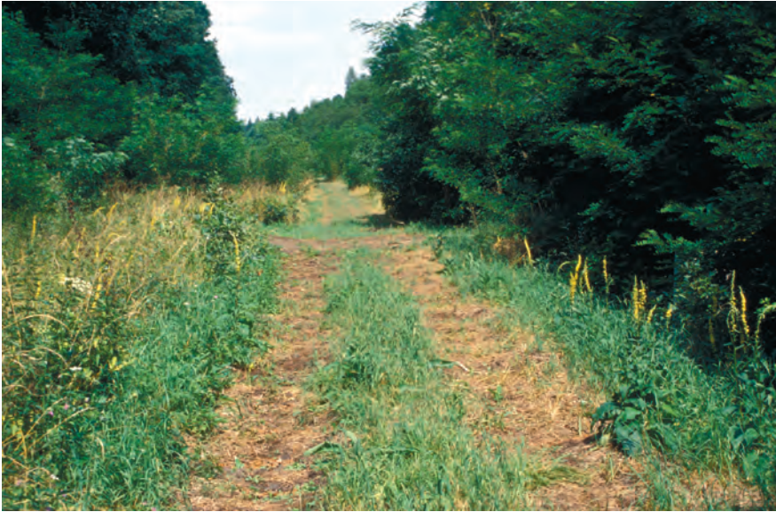
Fot. 42. Nielegalnie rozebrana nawierzchnia na części normalnotorowej linii Sieniawa Żarska–Jasiień (widok w kierunku północnym, 2002 r.)
