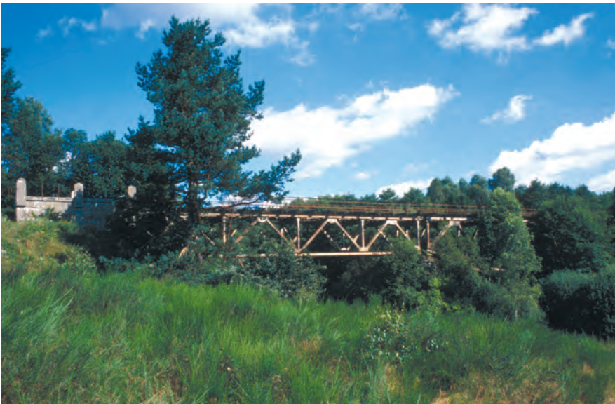
Fot. 30. Tak zwany „czerwony most” przez Grabową w Polanowie na rozebranej przez Armię Czerwoną normalnotorowej linii Polanów–Korzybie
