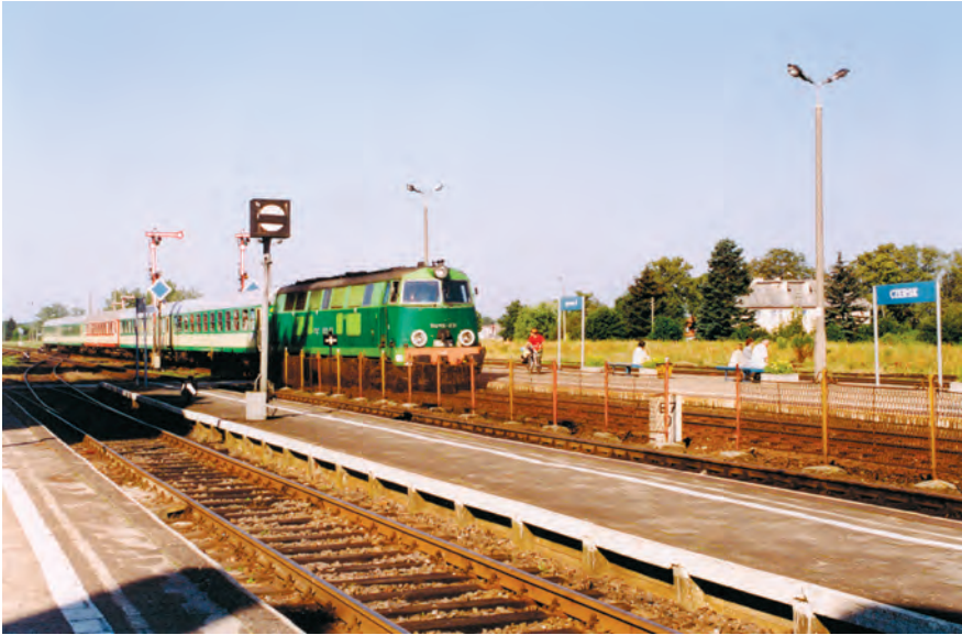
Fot. 19. Przykładem linii, która straciła na znaczeniu jest polski odcinek dawnej Królewsko-Pruskiej Kolei Wschodniej. Po 1945 r. częściowo zdemontowano drugi tor, linii nie zelektryfikowano, kursuje nią niewiele pociągów. Na zdjęciu jedyny pociąg pospieszny relacji Gorzów Wielkopolski–Gdynia Główna na stacji Czersk Pomorski w 2004 r.
