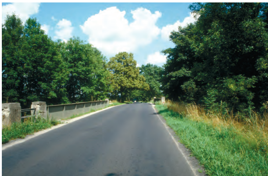
Fot. 14. Wiadukt drogowy nad przekopem nieuruchomionej linii Bąk–Liniewo w okolicy miejscowości Orle
