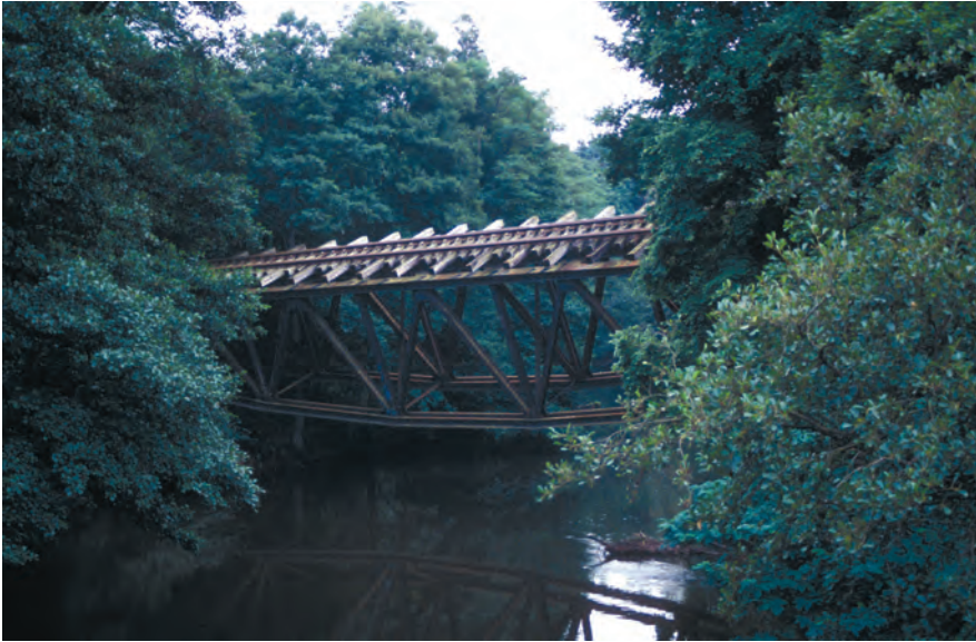
Fot. 32. Wysadzony most przez Gwdę w Piecewku, z zachowanym oryginalnym torem z 1914 r., na rozebranej przez Armię Czerwoną normalnotorowej linii Złotów–Jastrowie
