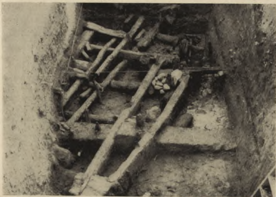
Ryc. 95. Kołobrzeg—Budzistowo. Konstrukcje wzmacniające wał z 2 połowy X w.
