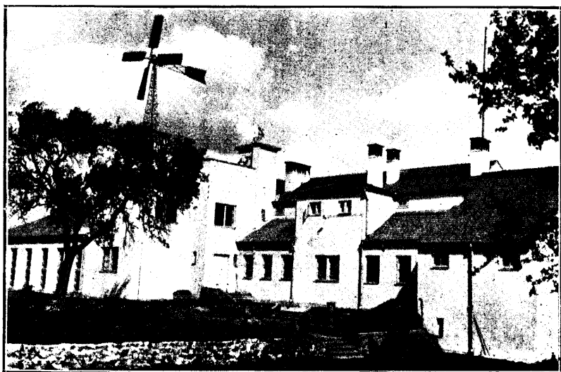
Rys. 2. Stacja Hydrobiologiczna. Budynek główny.
