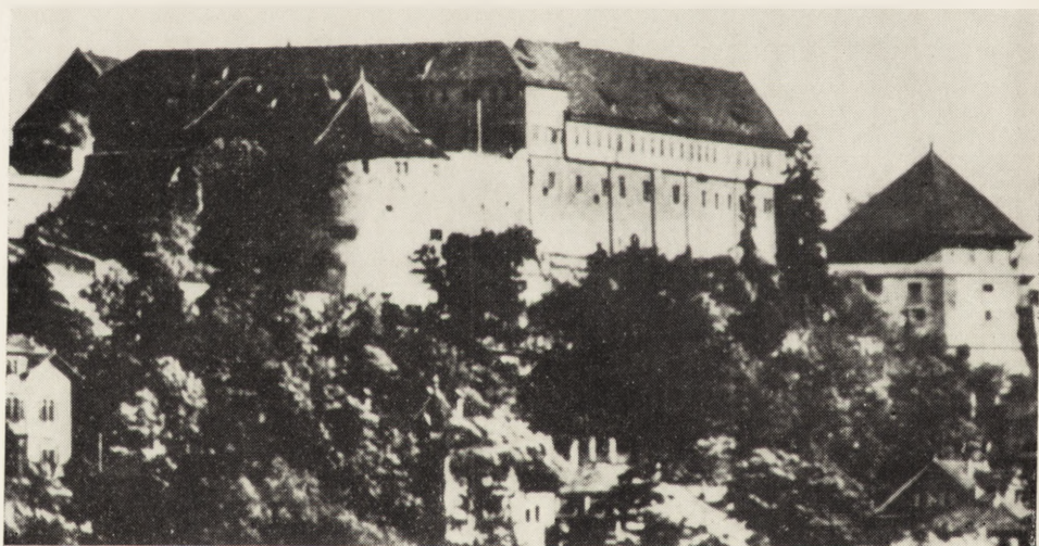
Rys. 3. Zamek nad rzeką Neckar w Tybindze, gdzie mieściło się laboratorium biochemiczne F. Hoppe-Seylera i gdzie F. Miescher odkrył nukleinę
