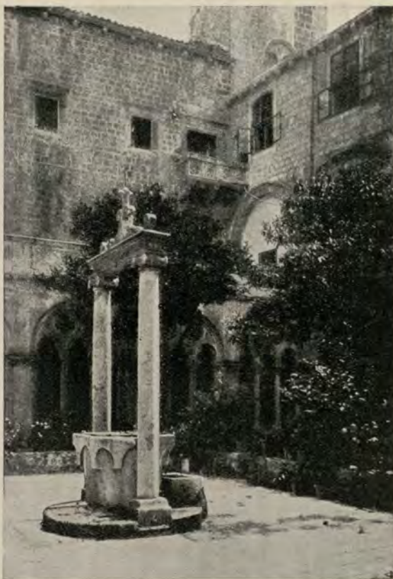
Podwórzec klasztoru dominikanów w Dubrowniku.
