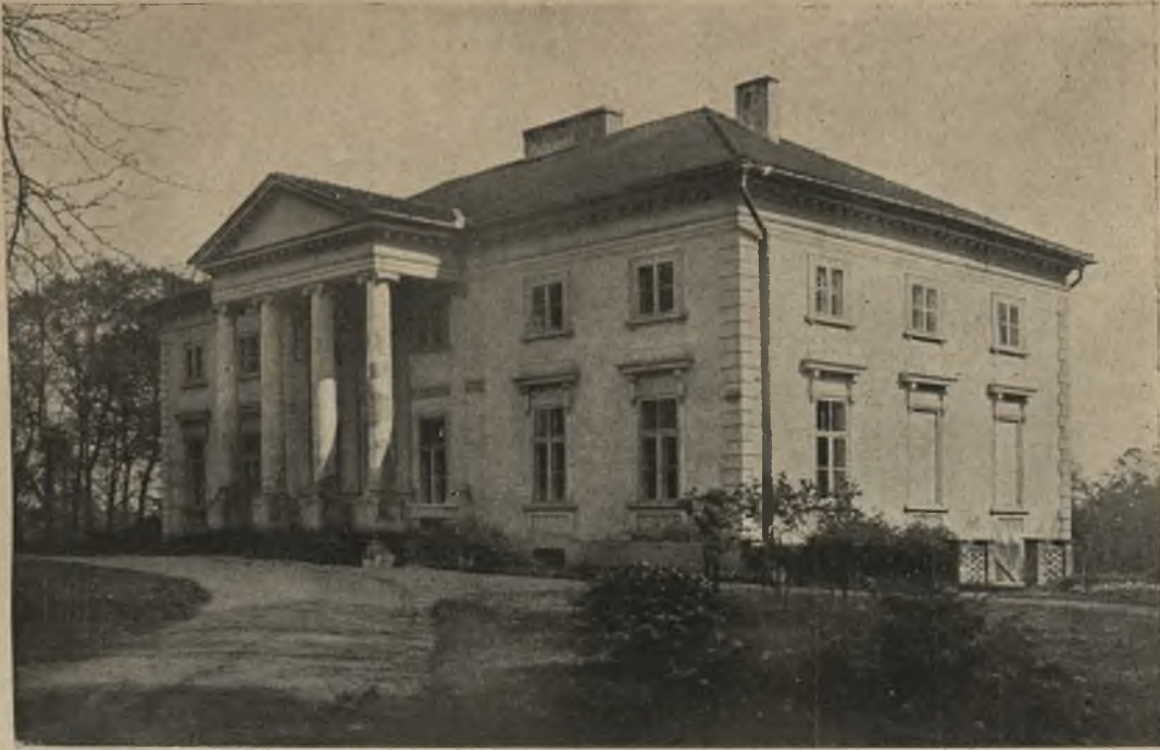
Fig. 17. PAŁAC W IGOŁOMJI. Widok od strony zajazdu.
