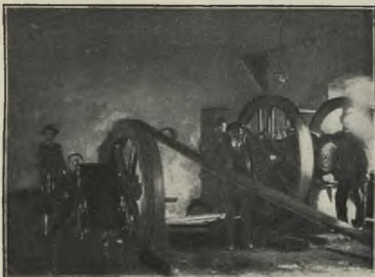
MOTORY ELEKTROWNI ZAKŁADU.
