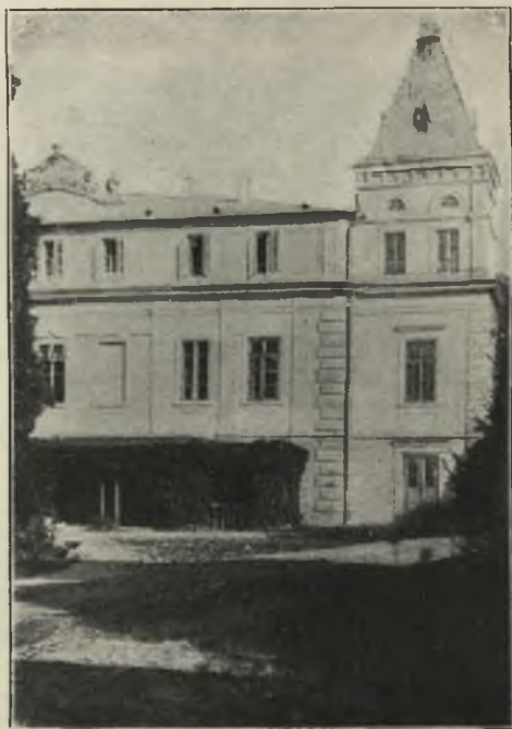
PAŁAC OD STRONY PODJAZDU (zachodniej).
