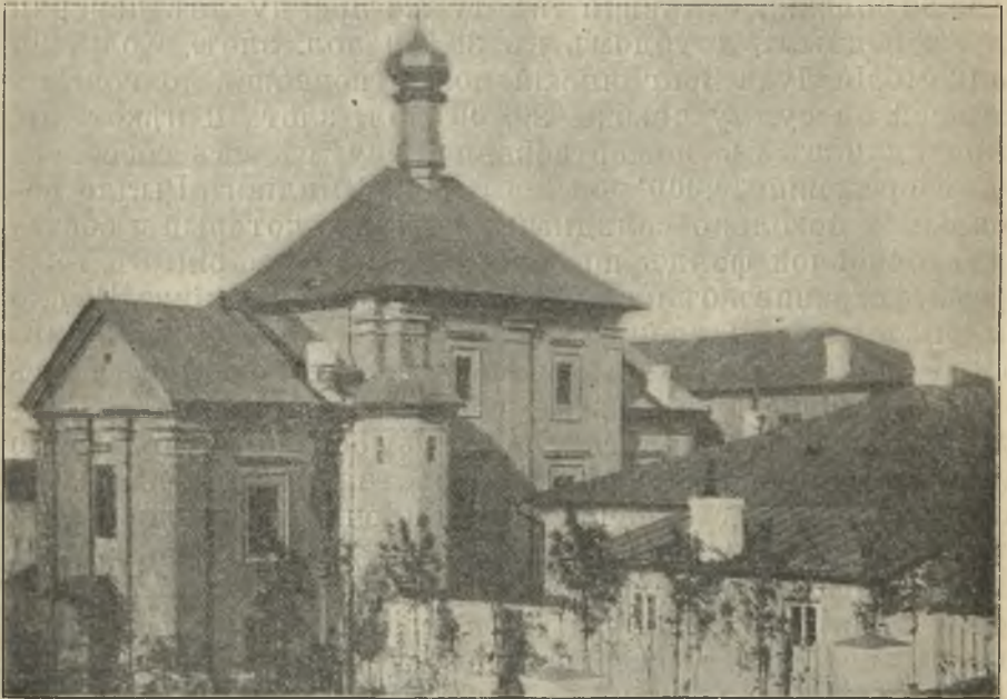
Вя́шній видъ стараго зданія духовной семинаріи и Николаевской церкви съ юго-западной стороны.
