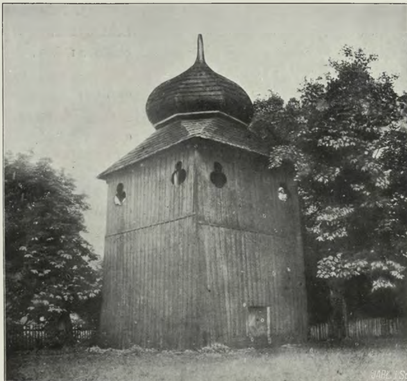
Fig. 147. Otwinów. Wieża kościoła parafialnego.
