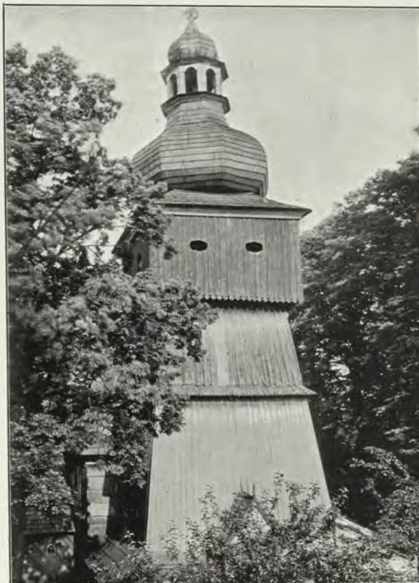
Fig. 120. Zembrzyce. Wieża dawnego kościoła.
