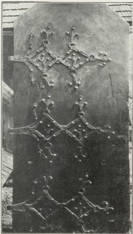
Fig. 96. Szywnald. Okucie drzwi głównych.
