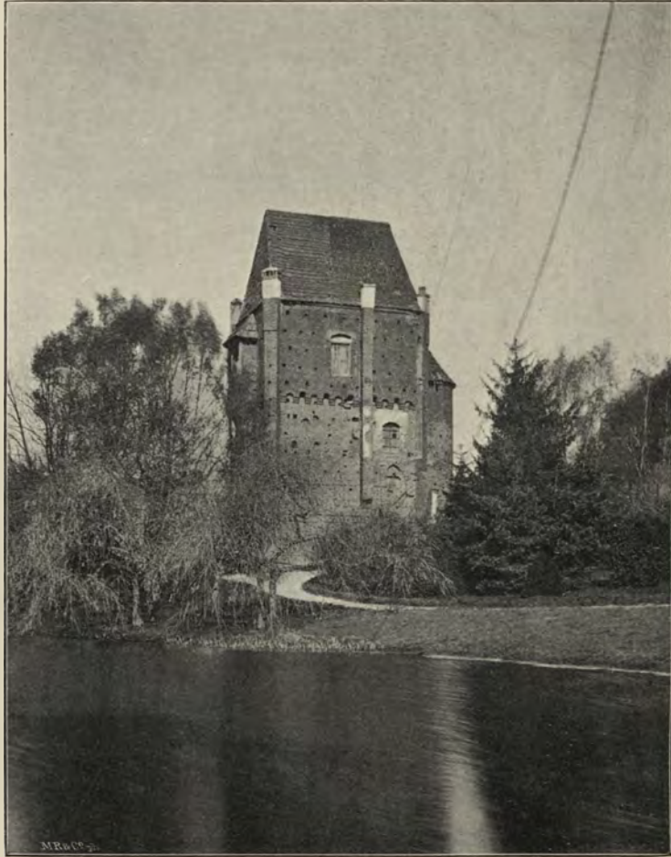
Abb. 47. Schlofsturm in Samter. Südostseite.
