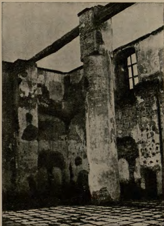
ŚWIĄTYNIA PO-BAZYLJAŃSKA NA KOŁOŻY (XI—XII w.). Otwory głośników (garnków akustycznych), widoczne w ścianie północnej, wewnątrz świątyni.
