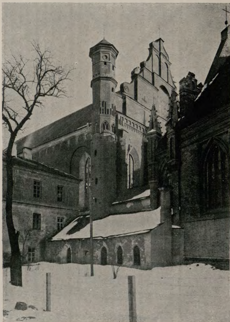
29. Die Bernhardinerkirche von Nordwest; der kleine Vorbau die Sakristei der St. Annenkirche.
