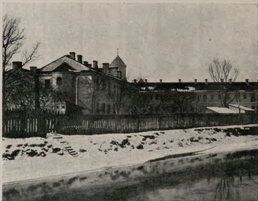
75. Der apsidenartige Ausbau am Frauenkloster.
