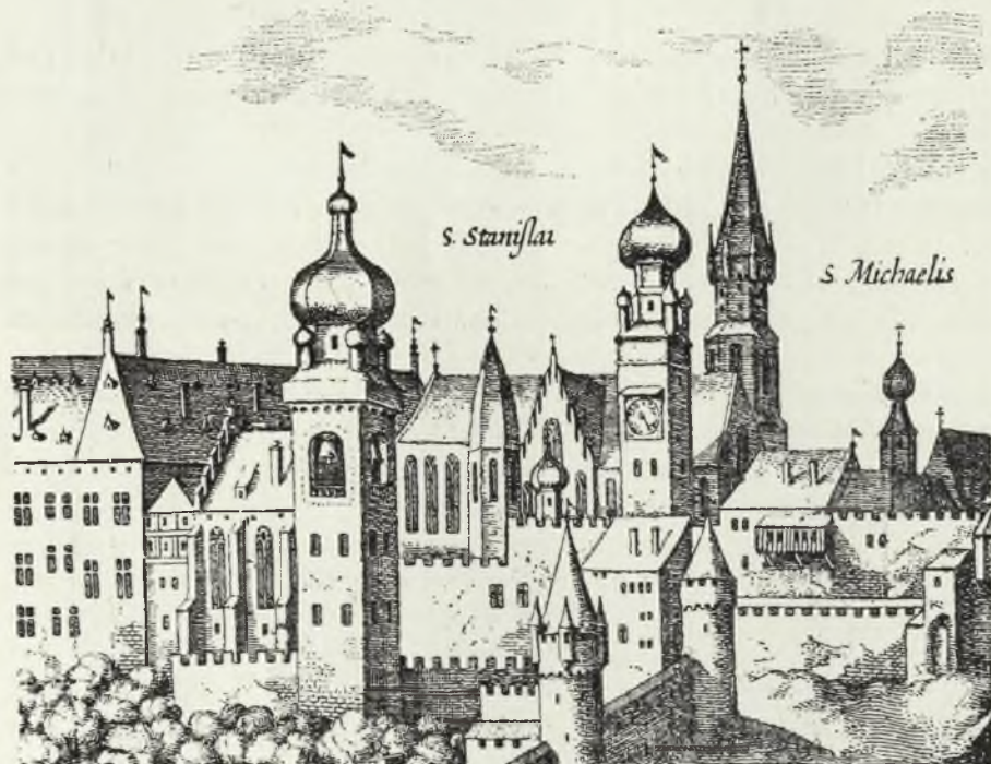
Rys. 80. Widok Katedry krakowskiej, ze skarbcem i obwarowaniem przy końcu XVI stulecia. (Wszystkie wieże mają wieżyczki narożne w duchu »stylu nadwiślańskiego«.)
