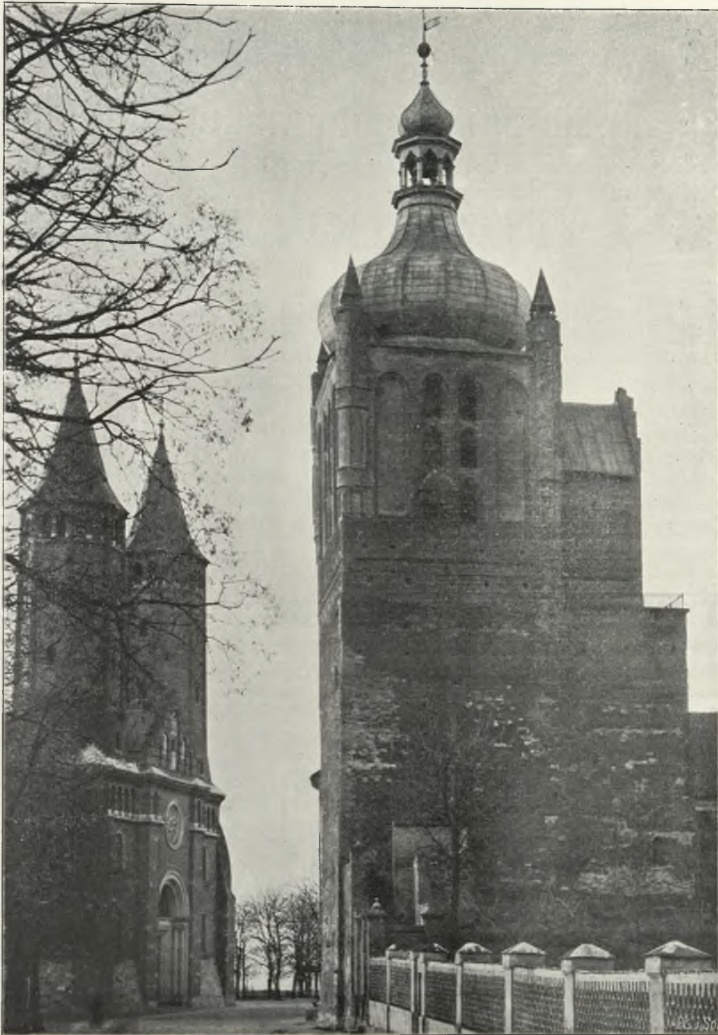
Wiz. 112. Dzwonnica przy katedrze z widokiem na wystawę przednią katedry, niegdyś wieża zamkowa. Architektura dzwonnicy na zasadzie »d w u d z i a ła u« rozwinęta i z dwu na łą cz a m i na o ś i. Po rogach cztery wieżyczki, niegdyś ostre pewnie i strzeliste — dziś skromne. (Fot. A. Grzywińskiego).
