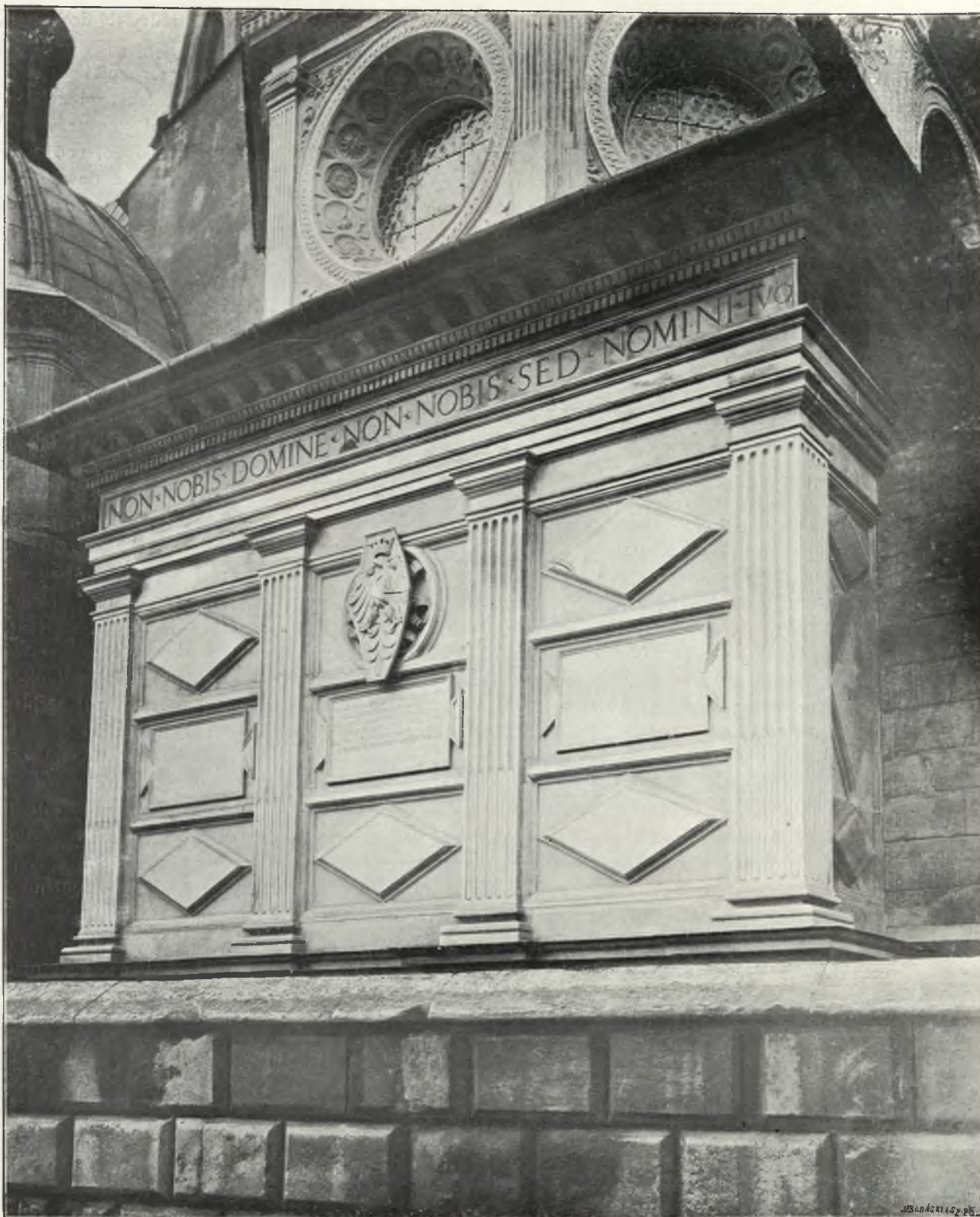
Wiz. 76. Widok na ścianę południową kaplicy Jagiellońskiej, ze słupami uwiecznymi (czyli pilastrami) porządku tokańskiego. Cała ściana z kamienia szydłowieckiego. W polu środkowym u góry orzeł polski, z przewiniętą literą S. (Orzeł Zyguntowski). W głębi po lewej zaznacza się kopuła kaplicy Wazów.
