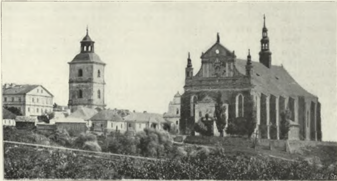
Wiz. 141. Widok katedry od strony zachodniej wraz z dzwonnicy obok. Na dachu sygnaturka dawniejsza, mniejsza. W głębi po lewej Dom księży Emerytów.
