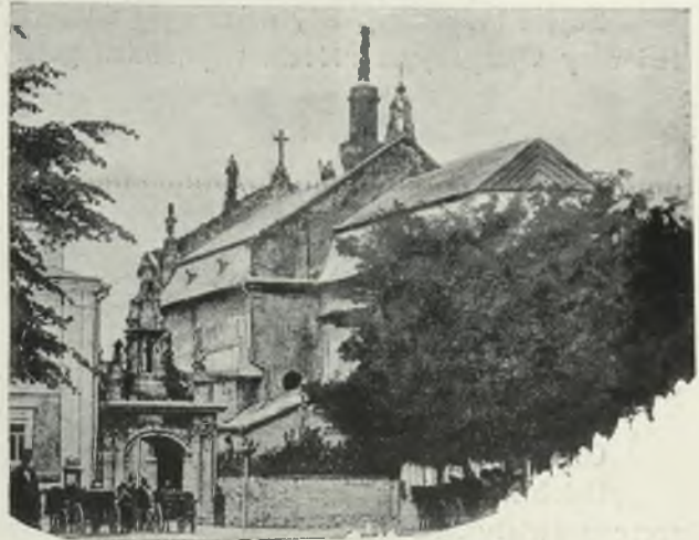
Wiz: 161. Widok katedry Kamienieckiej od strony części kapłańskiej. Na przedzie ozdobna bramka barokowa.
