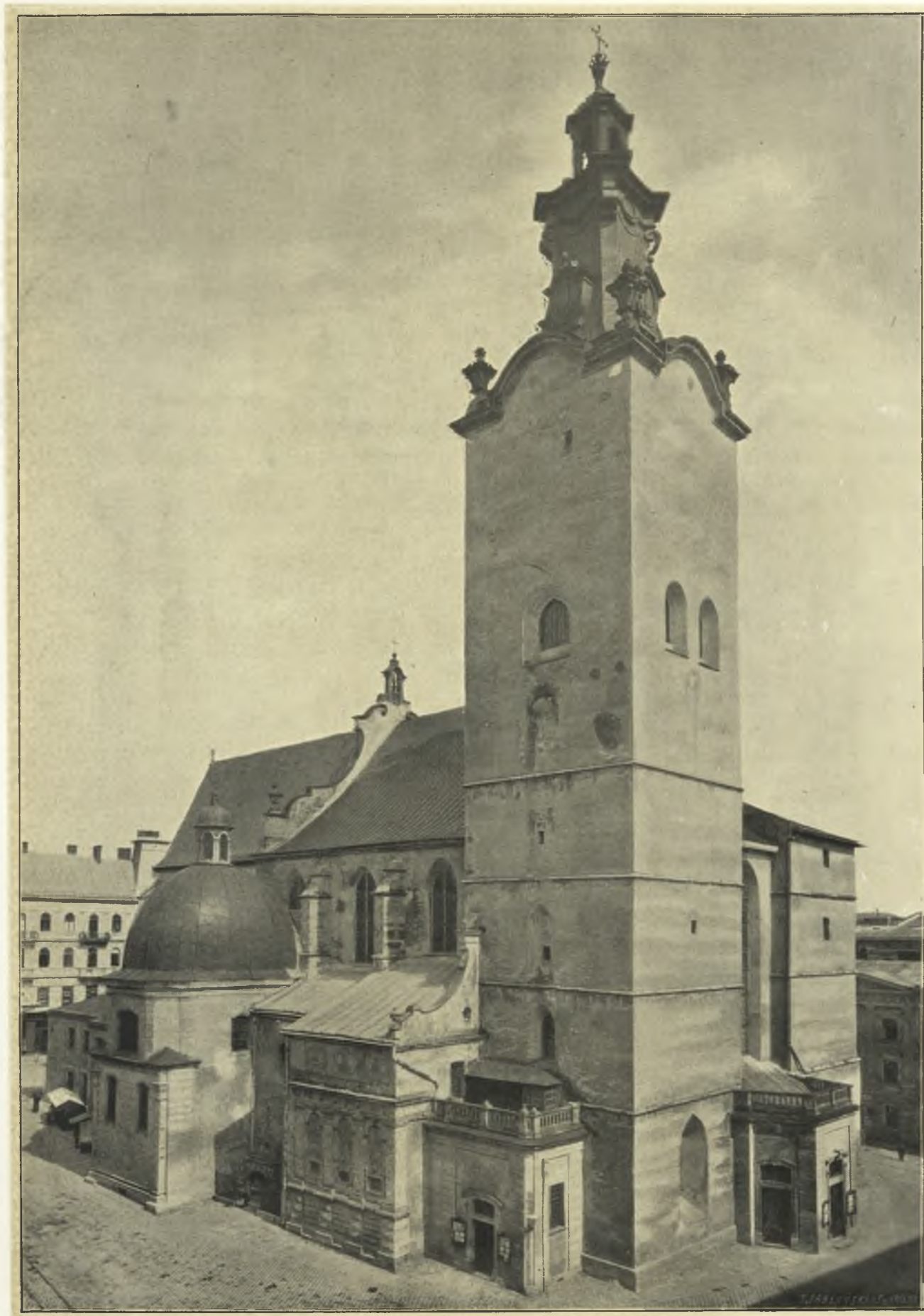
Wiz. 42. Widok Katedry Lwowskiej od strony północno-zachodniej. — Po boku widać kaplicę Najśw. Sakramentu z kopułą — a przed nią kaplicę P. Jezusa, czyli K a m p i a n ó w.
