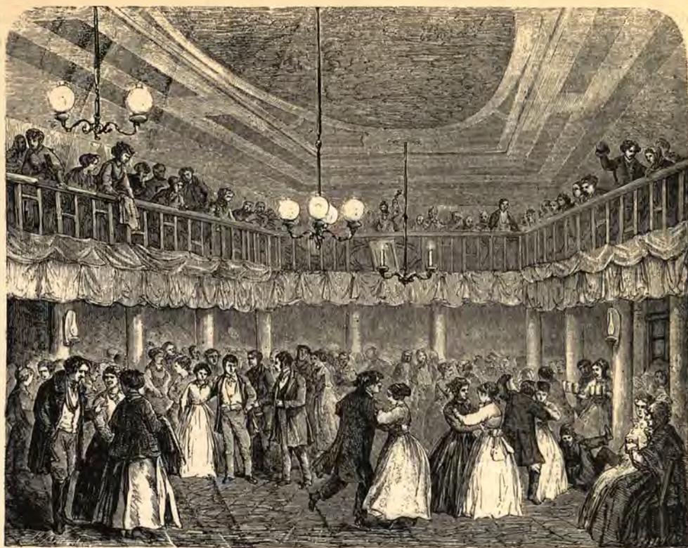
Sala tańców przy ulicy Waliarów.
