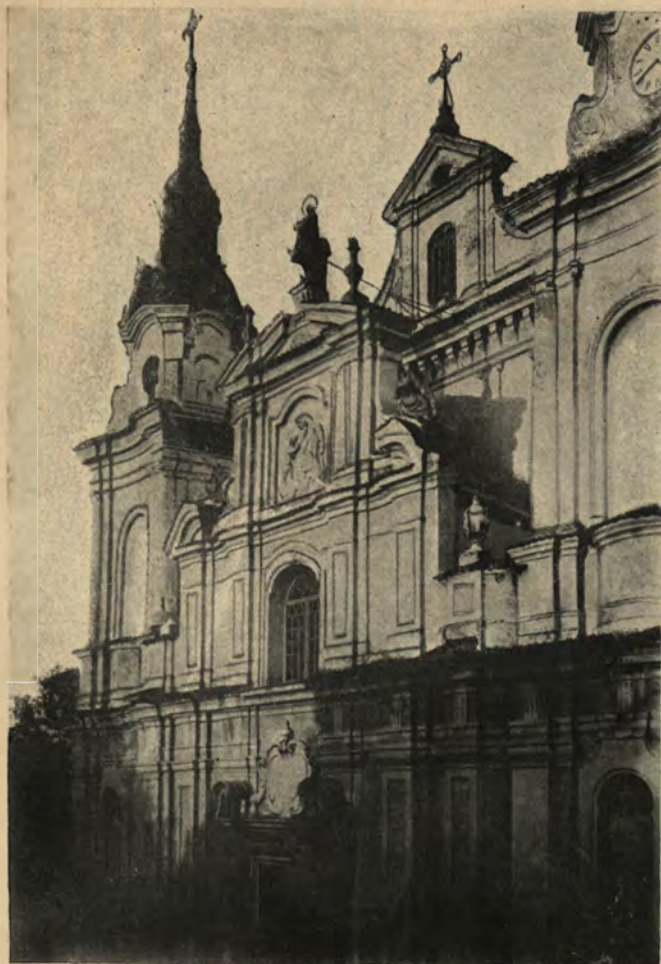
Rys. 33. Lubartów, fara, elewacja frontowa z dzwonnicy.
