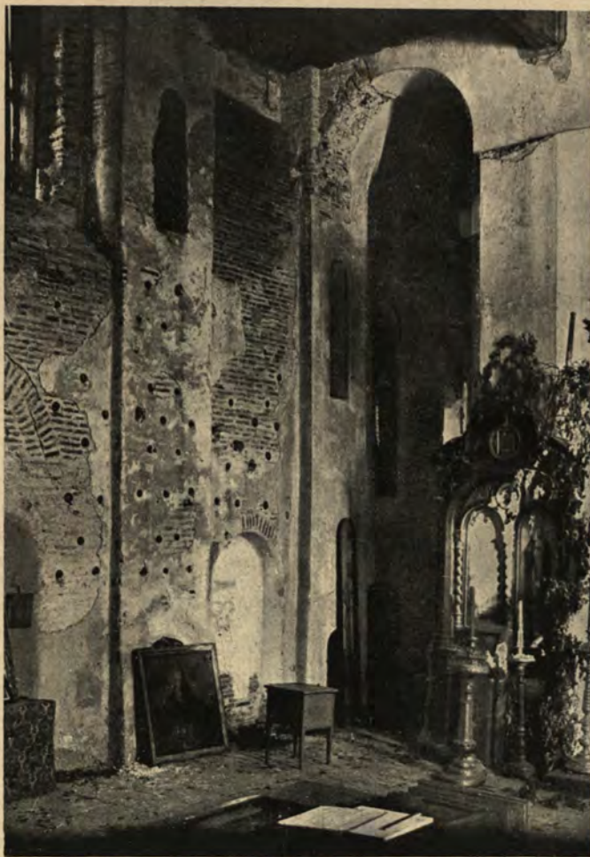
Rys. 36. Kołoza. Wnętrze cerkwi przy północnej absydzie.
