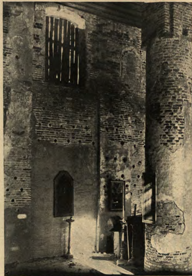
Rys. 37. Kołoza. Wnętrze cerkwi, fragment ściany północnej.
