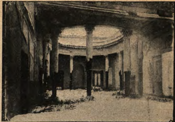
Sala kolumnowa w pałacu ks. Lubomirskich w Dubnie.
