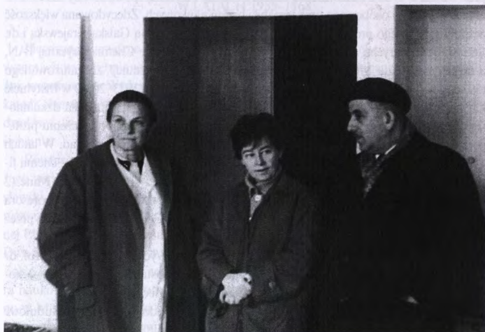
Fot. 9. Rok 1963. W budowanym właśnie skrzydle Chemii Fizycznej.
