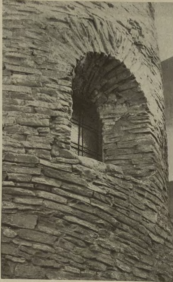
Boczna ściana kościoła św. Feliksa i Adaukta.
