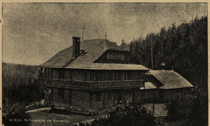
Śląsk Ciesz. Wisła. Schronisko na Baraniej Górze.
