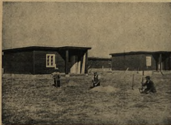
Naramowice: budowa płotu.
