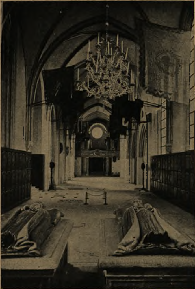
Upsala. Wnętrze kościoła.
