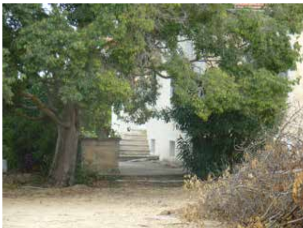
Odbudowany po trzęsieniu ziemi
