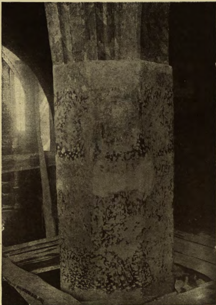
Część słupa w nawie głównej po odbiciu nowego tynku, przed zapunktowaniem
