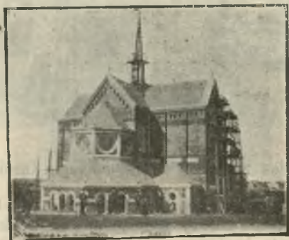
Zewnętrzny widok nowego Kościoła.
