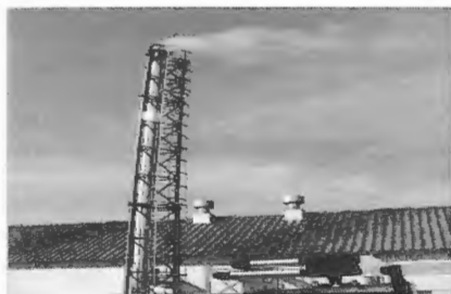
Rysunek 1. Emisja z komina przy wyłączonej instalacji suszarni
