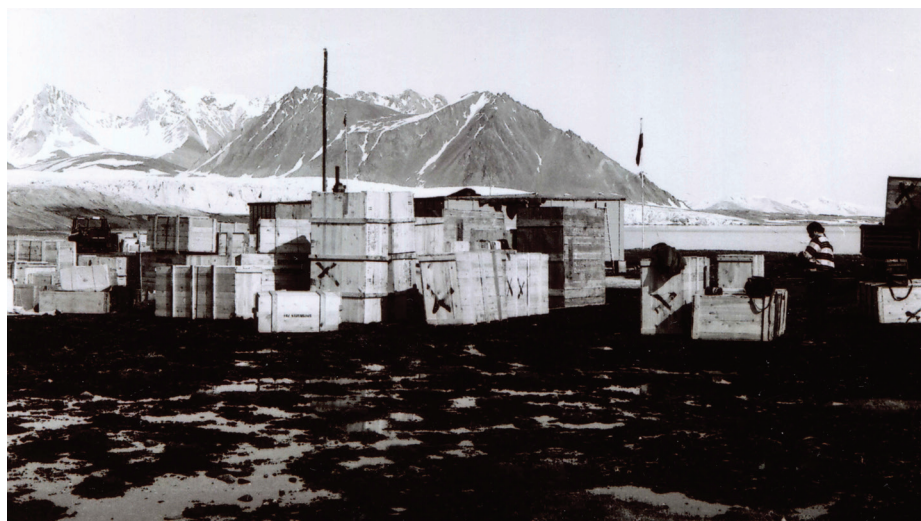
Fot. 46. Polska Stacja Polarna w Hornsundzie w czasie budowy
