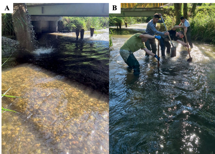
Fot. 1. Odtwarzanie tarliska: A – wsypywanie żwiru do koryta rzecznego, B – rozprowadzanie żwiru po bystrzu (fot. M. Bień)
